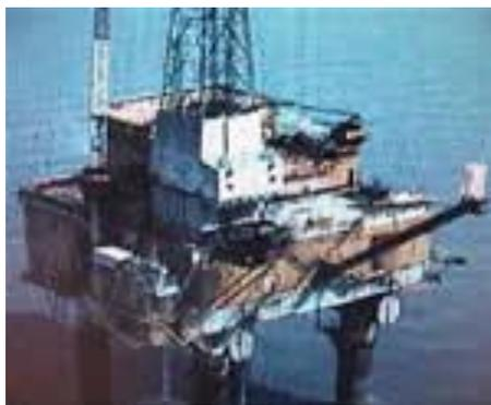
Las compañías perforan varios pozos desde la misma plataforma. Las plataformas “Platform rigs” pueden ser plataformas asistidas por un barco “tender assisted rigs”.
