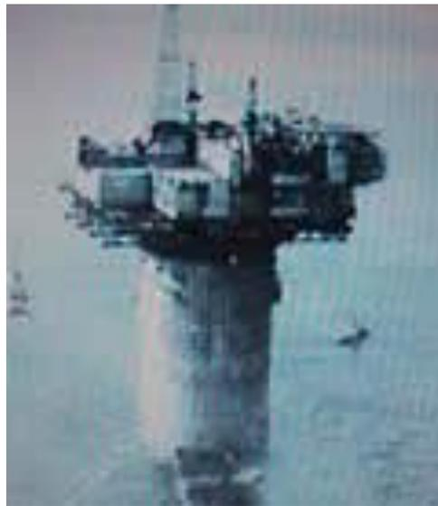
3. Plataforma con pilares de concreto “Concrete Gravity Type Platform”.
